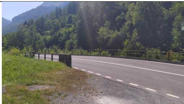
Blick nach Süden, unübersichtliche Situation, dank dem Spiegel (rechter Bildrand) wird die Sicht um die Kurve verbessert.
