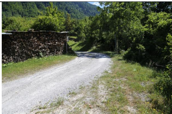
Blick bergwärts, die Güterstrasse führt zwischen Dammschüttungen hindurch
