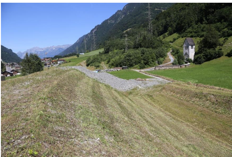
Foto Nr. 2: Blick vom bestehenden Schutzdamm in Richtung Nor- den, Rückhalteraum Schrund- /Teufrunse. Rechts im Bild: der geschützte Kirchturm.
