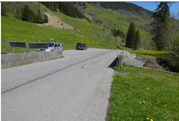
Situation beim nördlichen Rand des Ablagerungsstandortes, Blick Richtung Elm / Norden.
