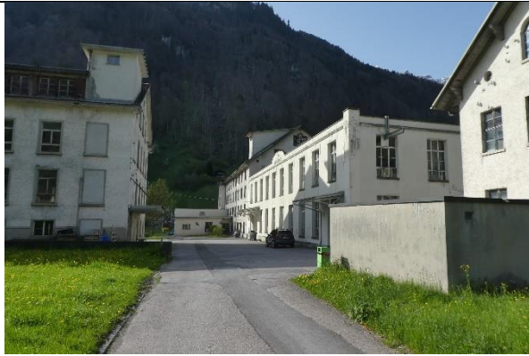
Blick Richtung Westen. Die Erschliessung führt zwischen Den Gebäuden des Legler-Areals hindurch (Markierung).
