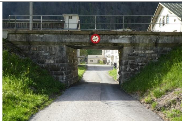
Blick von der Hauptstrasse Richtung Legler-Areal. Der Durchlass weist eine Höhe von ca. 2.9 m und eine Breite von 3.5 m auf.
