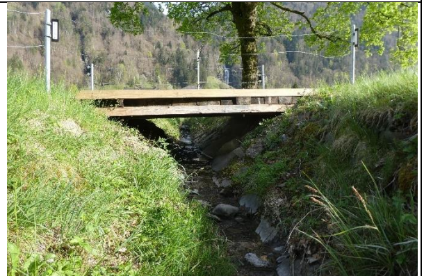
Brücke über die Tollruus, Blick gegen die Fliessrichtung
