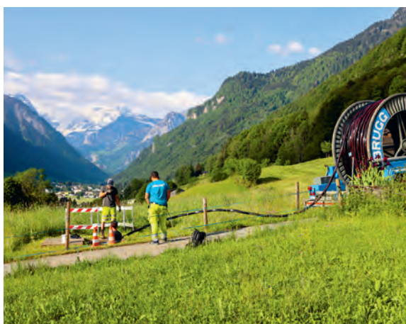
Kabelzug in der Alprüfi, Nidfurn.
