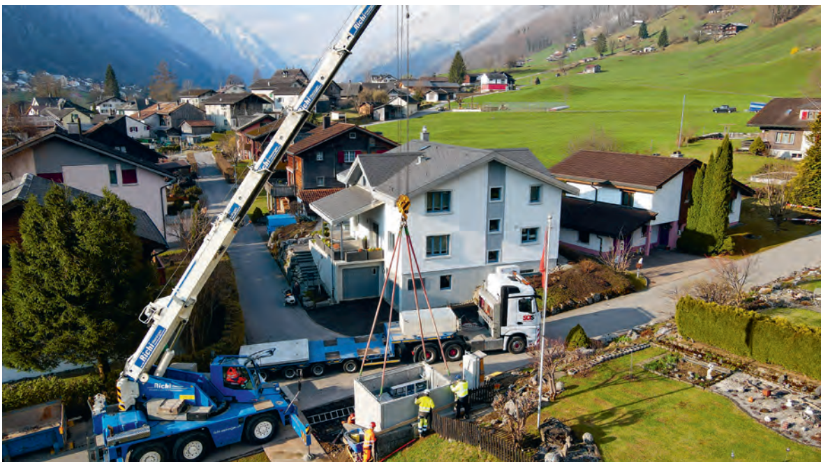
Ersatzneubau TS Addacher Nidfurn.
