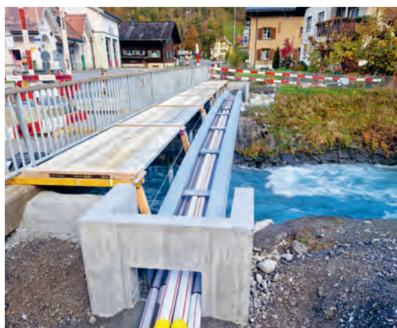
Neue Werkleitungsbrücke über die Linth in Linthal.
