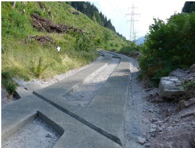
Abb.2 Beispielbild Betonfahrspur
