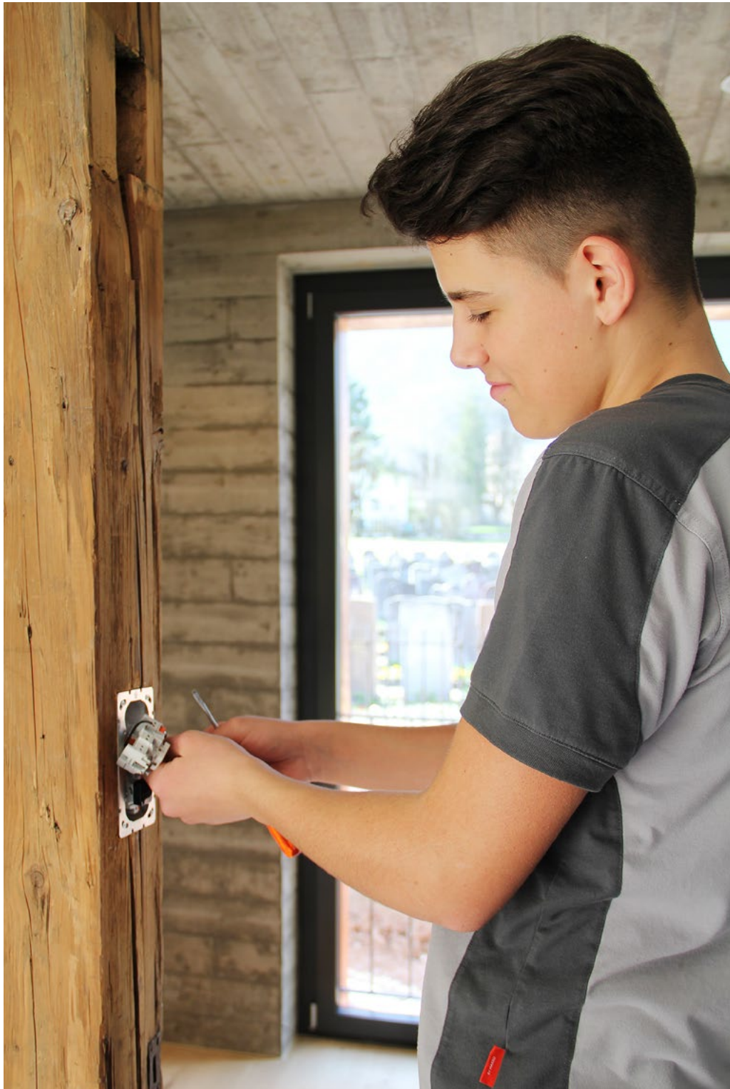
Arbnor Veliu beim Anschluss eines Schalters.
