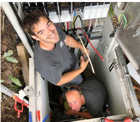
Sandro Zweifel und Sven Marti bei Verkabelungsarbeiten.
