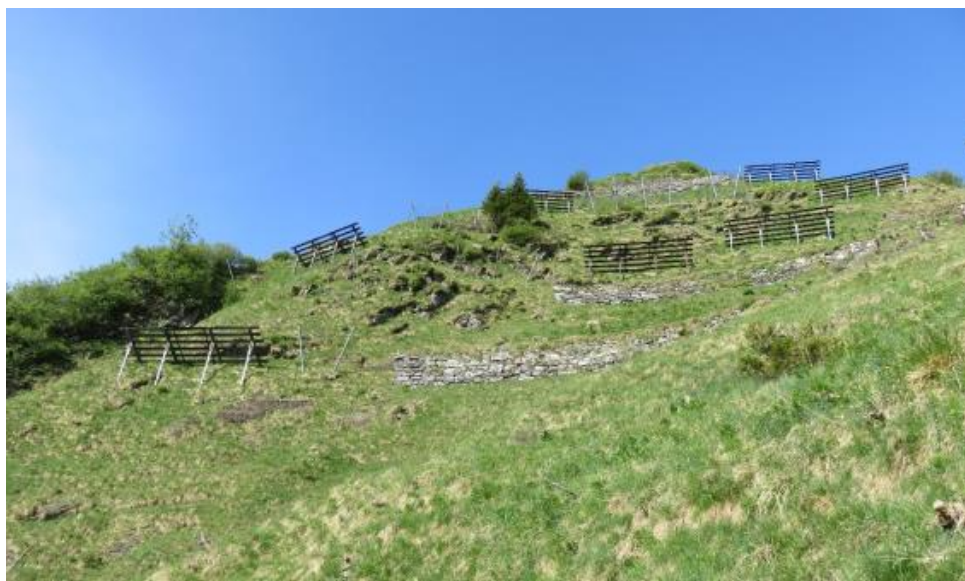
Abb. 10 Blick auf den obersten, unbewaldeten Bereich der Lawinenverbauungen Meissenplangge
